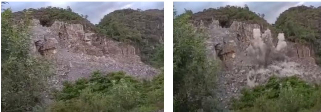
Hình 4.14. Vụ nổ mìn thực hiện trên mỏ đá vôi Phayú
